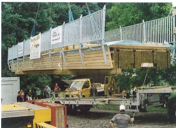
Nach Anlieferung der Blockträger (oben, links) zur Baustelle folgten der mehrlagige Aufbau der Fahrbahn (oben, rechts) sowie die Anbringung der Lärchholzverkleidung und des Geländers (links).
