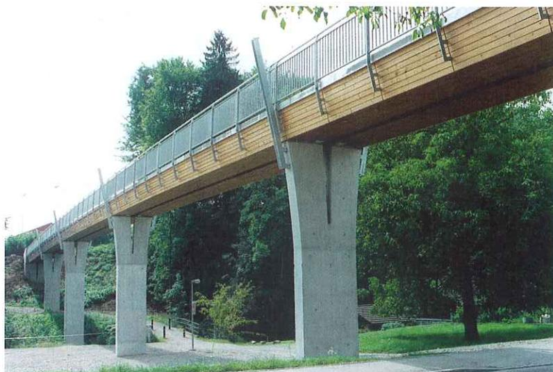
Mit allen wichtigen Teilen ausgestattet, erlaubten die vorgefertigten Brückenelemente eine effiziente Montageabwicklung (oben), so dass das fertige Objekt (links) termingerecht seiner Bestimmung übergeben werden konnte.
