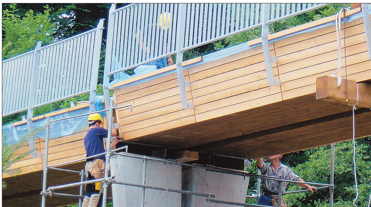
Zimmerei-Team beim Brückenschlag in Sins.
